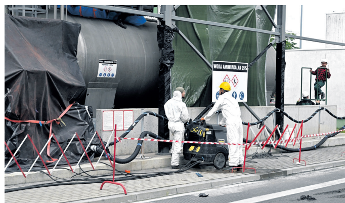
Pasywacja zbiornika do magazynowania wody amoniakalnej
