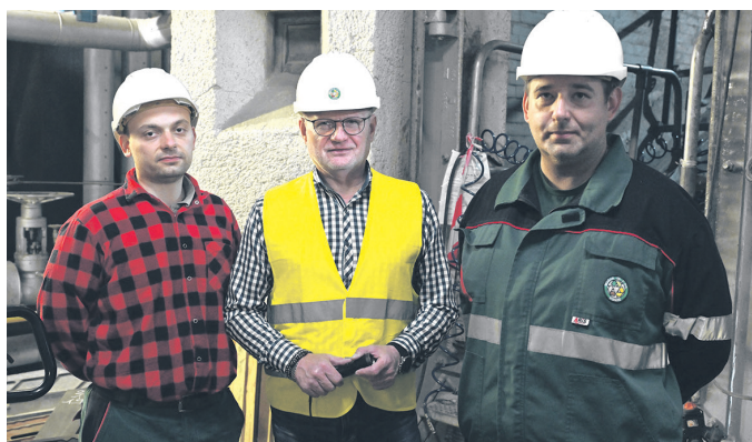
Kontrola postępu prac remontowych na terenie zakładu
