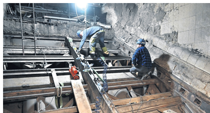
Demontaż rusztu wewnątrz kotła
