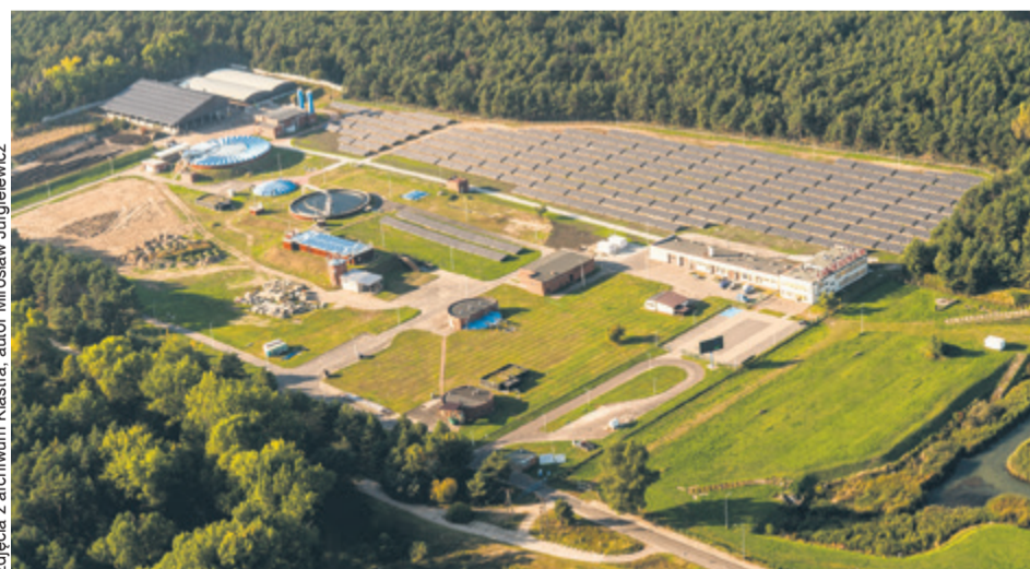
Farma fotowoltaiczna na terenie Oczyszczalni Ścieków
