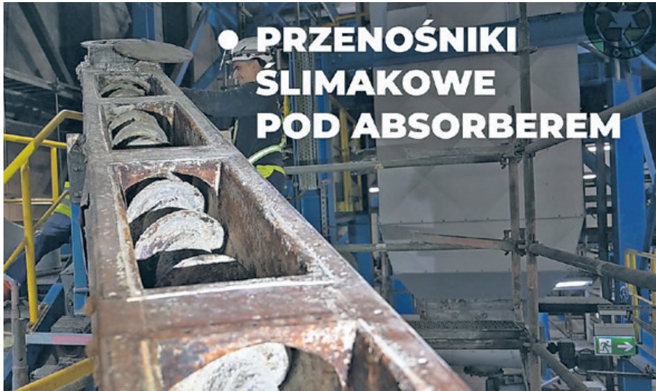
MONTAŻ NOWYCH PRZENOŚNIKÓW
