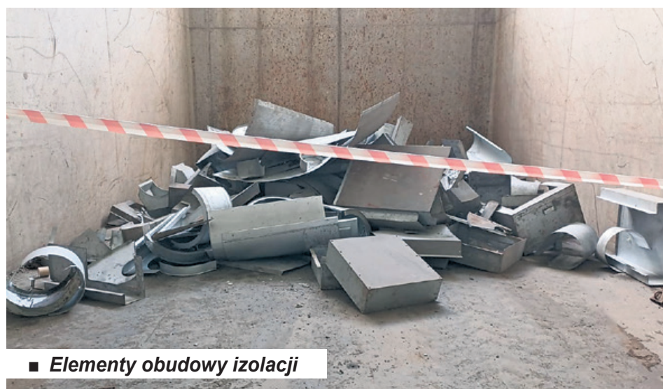
■ Wycięty fragment instalacji do złomowania
