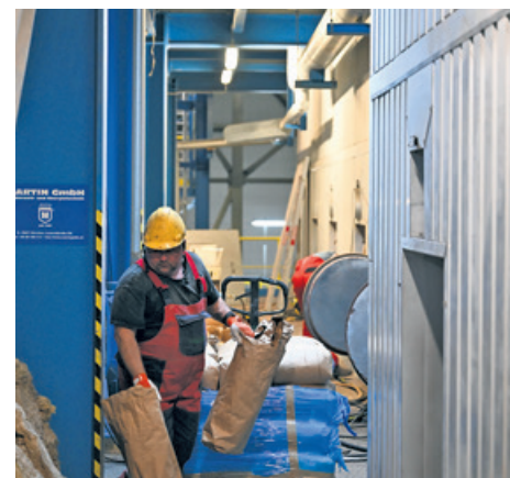
■ Przygotowanie do piaskowania kotła
