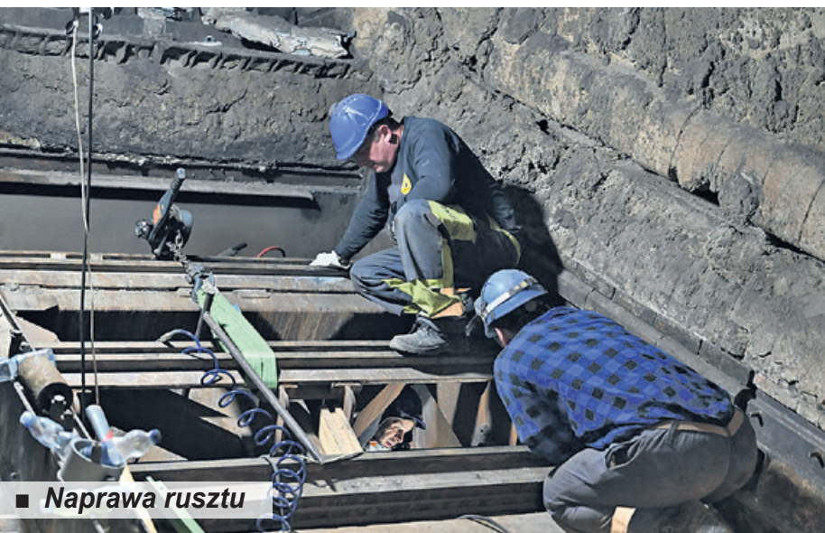
■ Naprawa kruszarki na instalacji oczyszczania spalin
