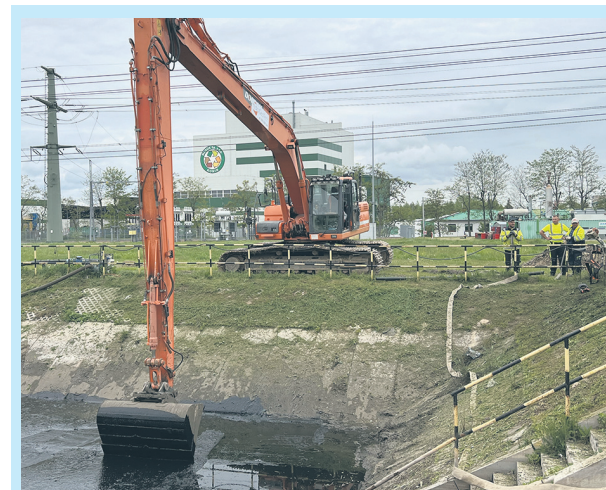
Czyszczenie zbiornika na odcieki
