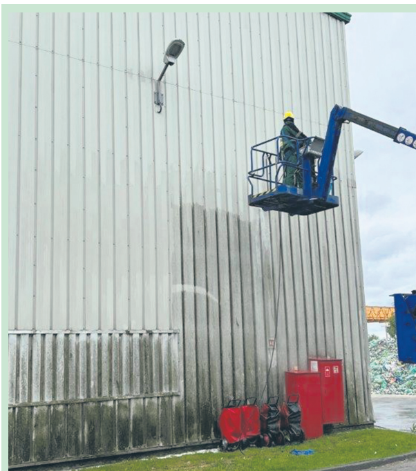
Pracownicy Sortowni myją elewacje
