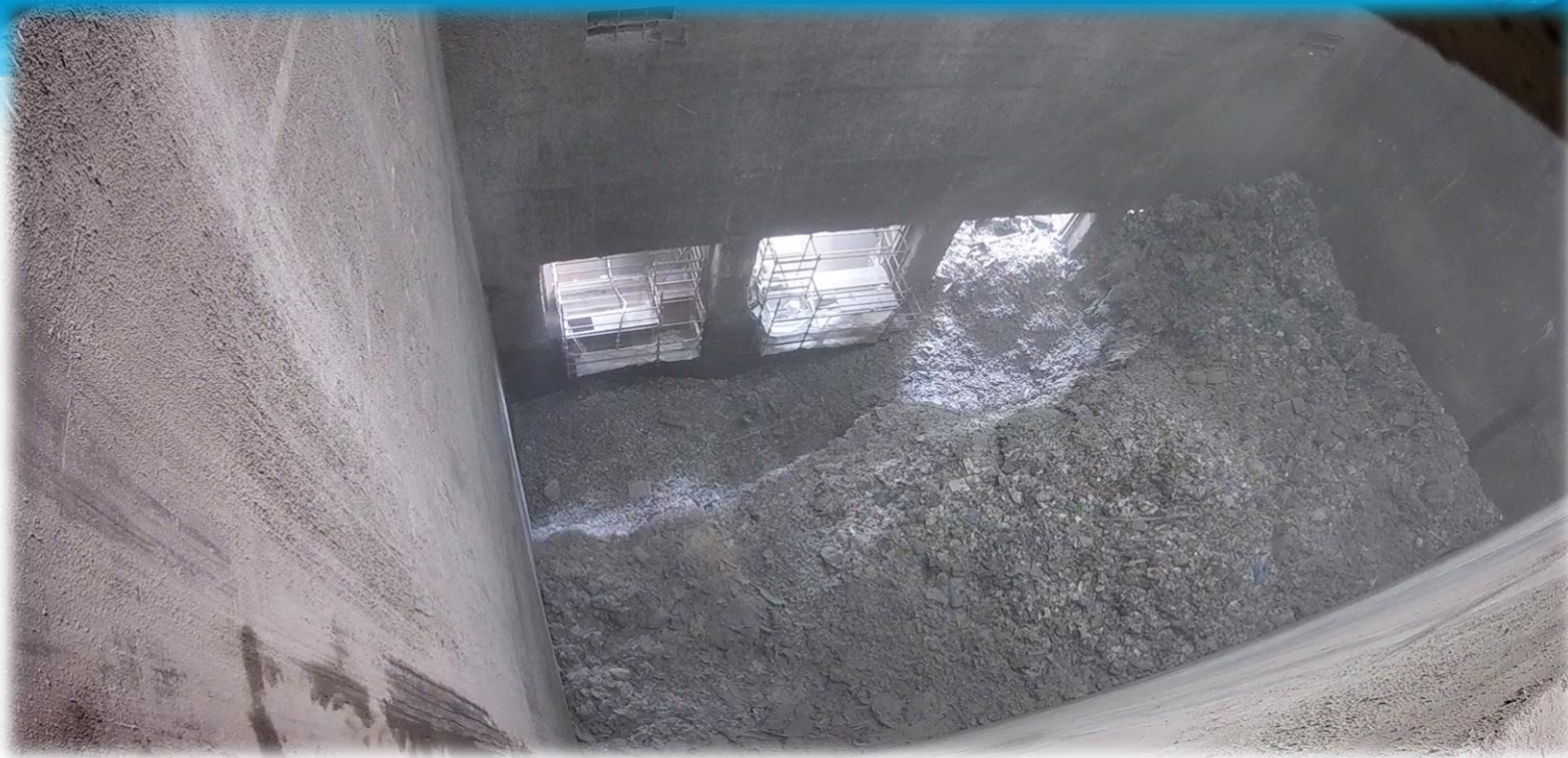
Przygotowania do prac spawalniczych w bunkrze odpadów
