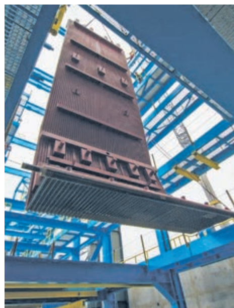
■ Montaż kotła, wrzesień 2014 r.
