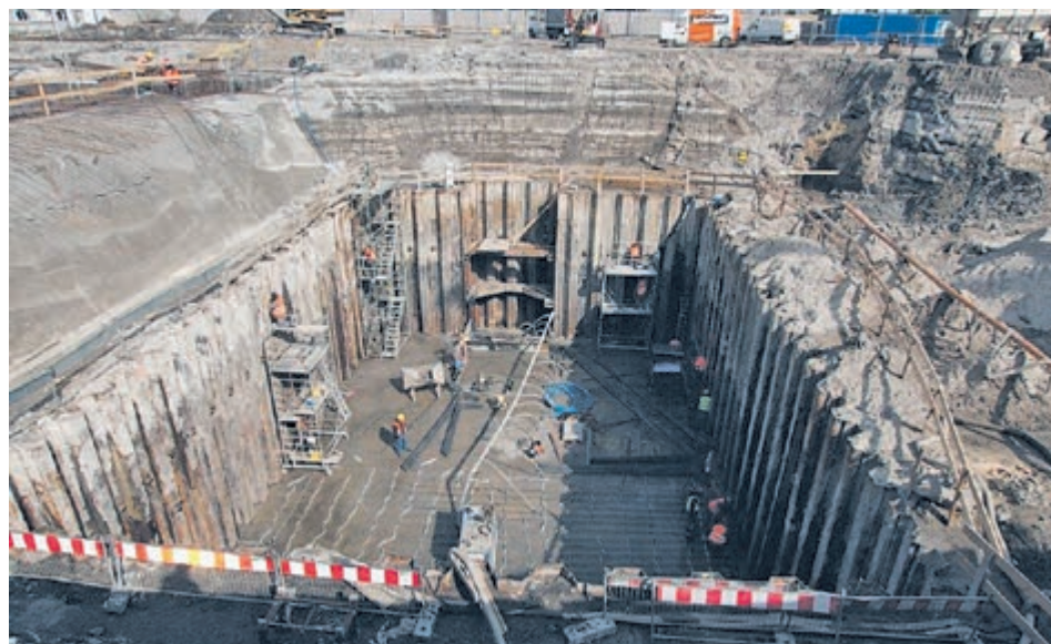
■ Wykopy pod budowę instalacji, kwiecień 2014 r.
