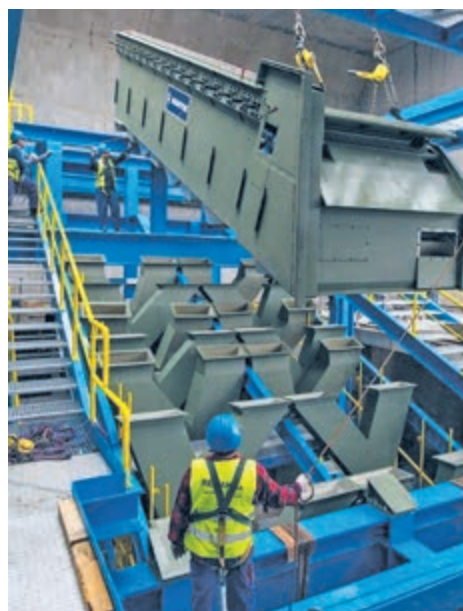
■ Montaż rusztu, wrzesień 2014 r.
