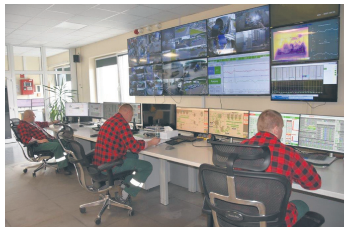
ZTUOK Operatorzy kotła i turbiny w nastawni
