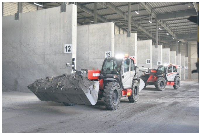
ZTUOK Operatorzy instalacji waloryzacji żużla
