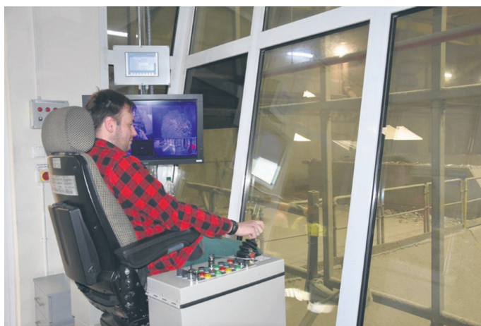
ZTUOK Suwnicowy – podawanie odpadów z bunkra na ruszt
