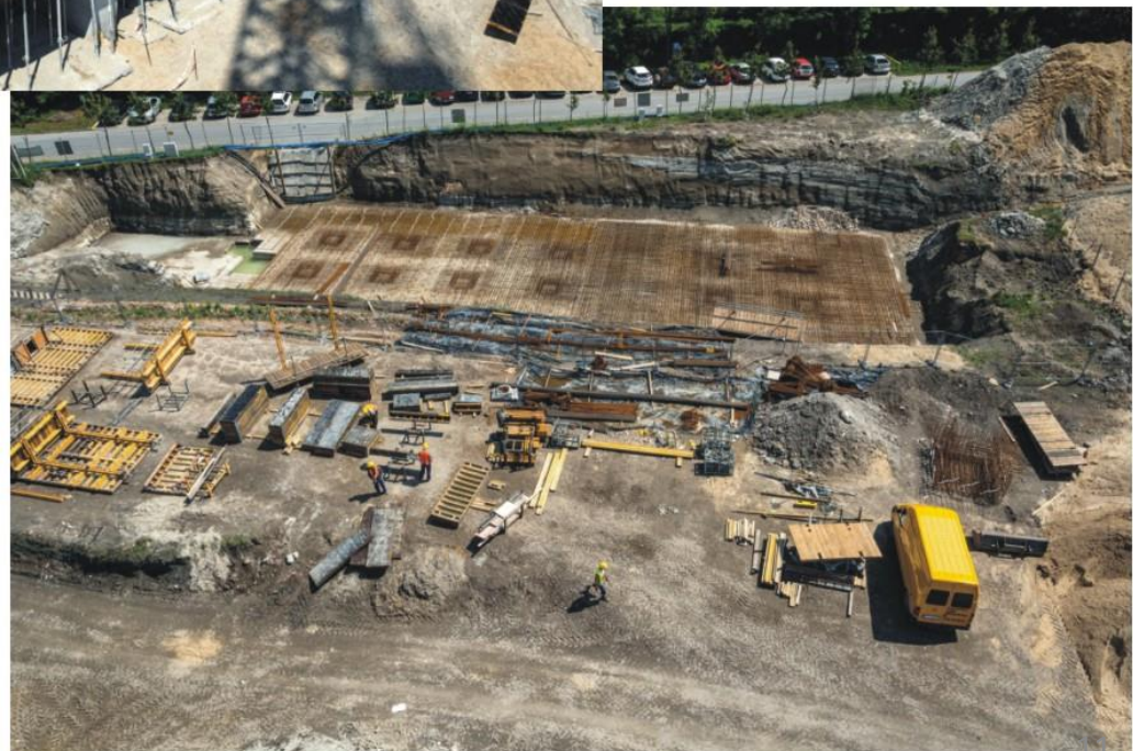
Płyta fundamentowa magazynu żużla
