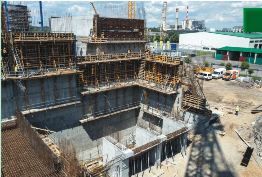
Płyta fundamentowa magazynu żużla
