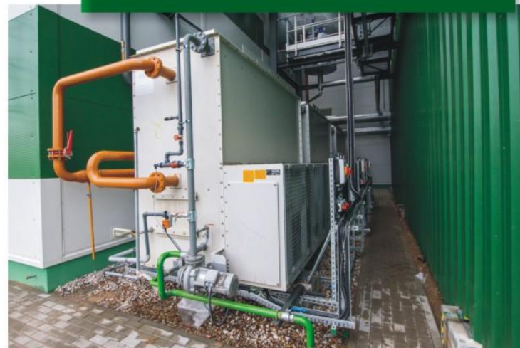
Stacja schładzania pary
