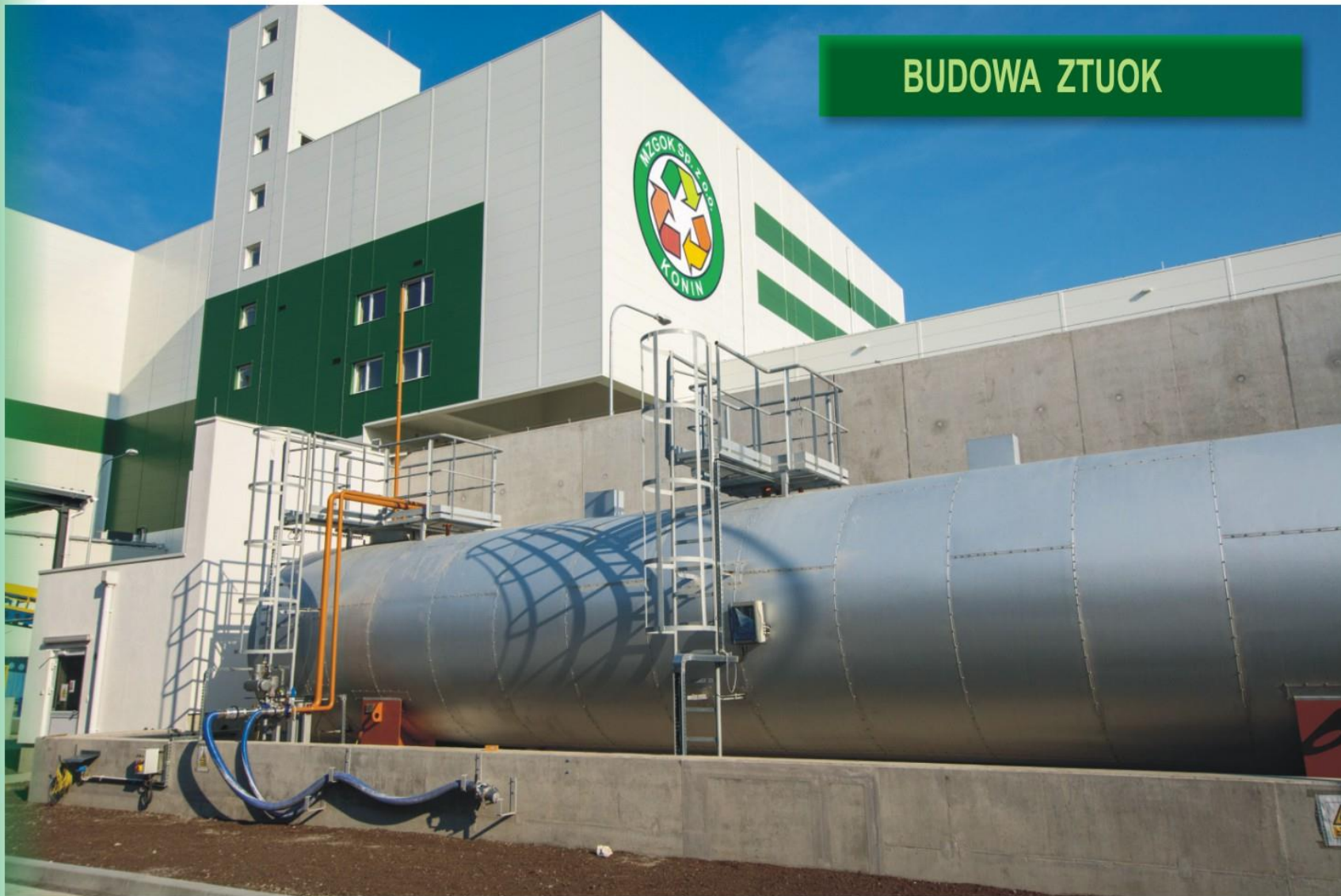
Zbiornik oleju lekkiego
