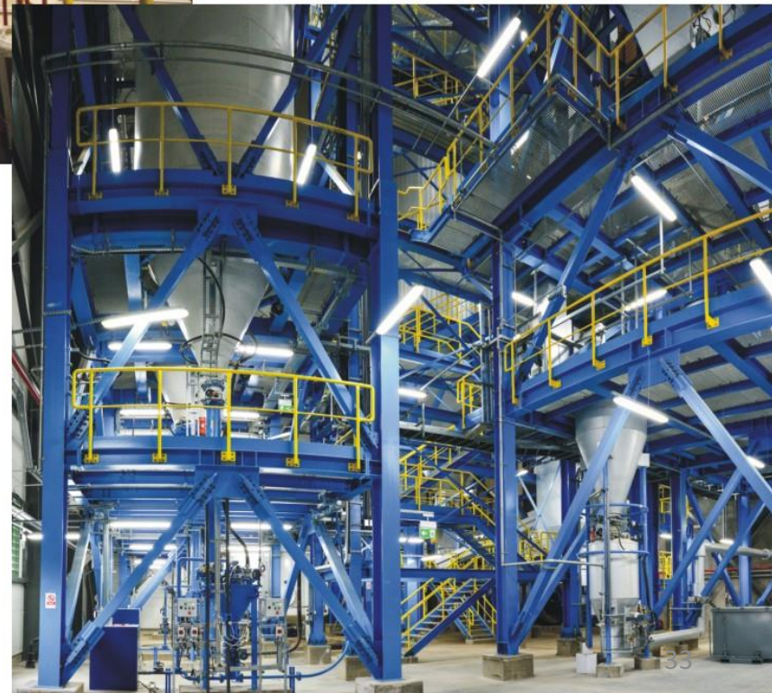
Hala oczyszczania spalin
