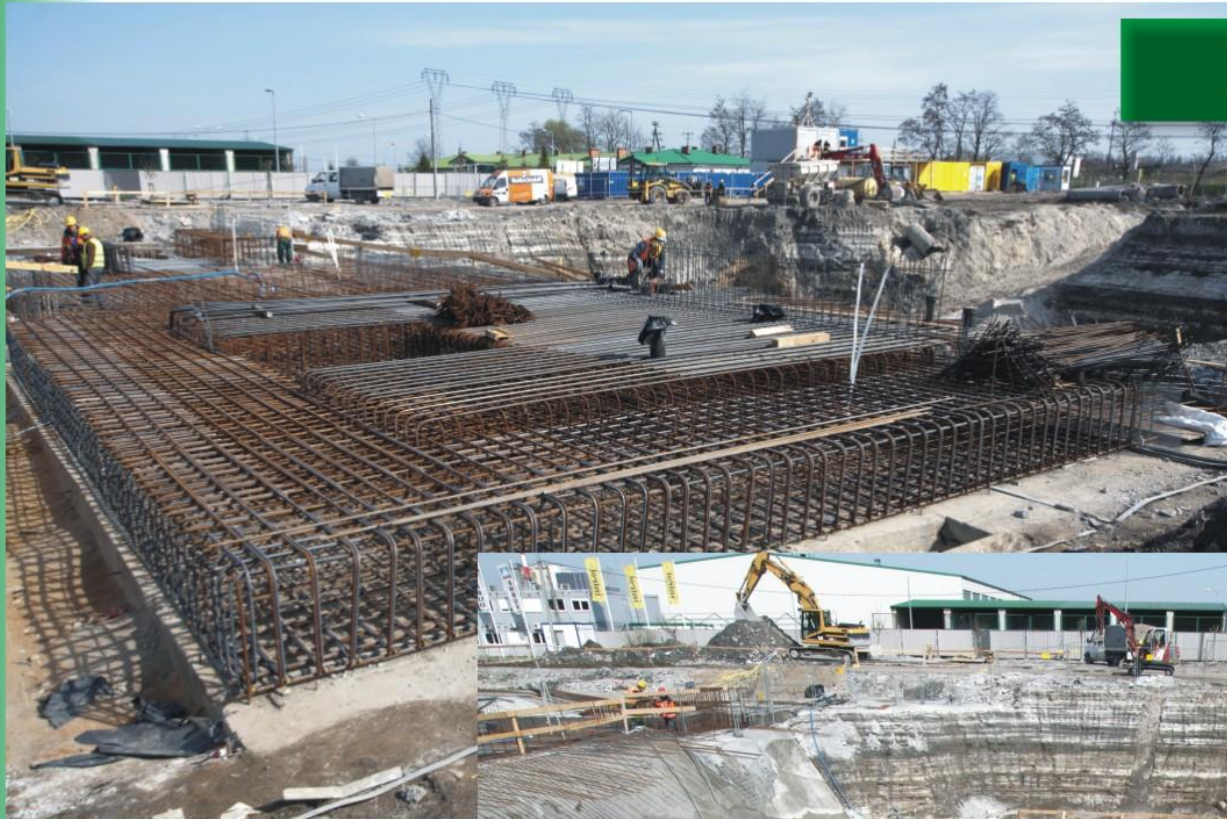
Płyta fundamentowa budynku kotłowni
