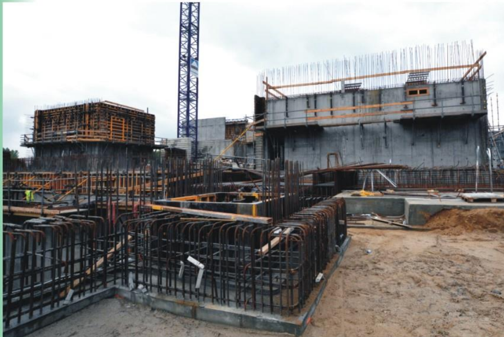
Płyta fundamentowa hali oczyszczania spalin
