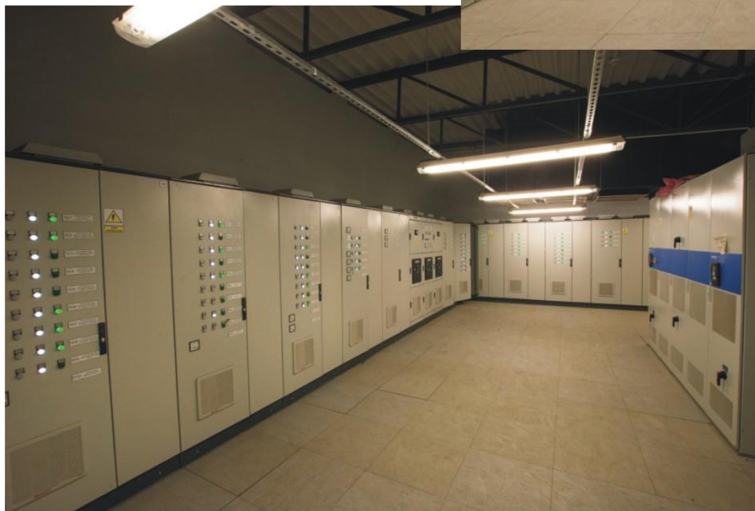
Rozdzielnia elektryczna dla instalacji oczyszczania spalin
