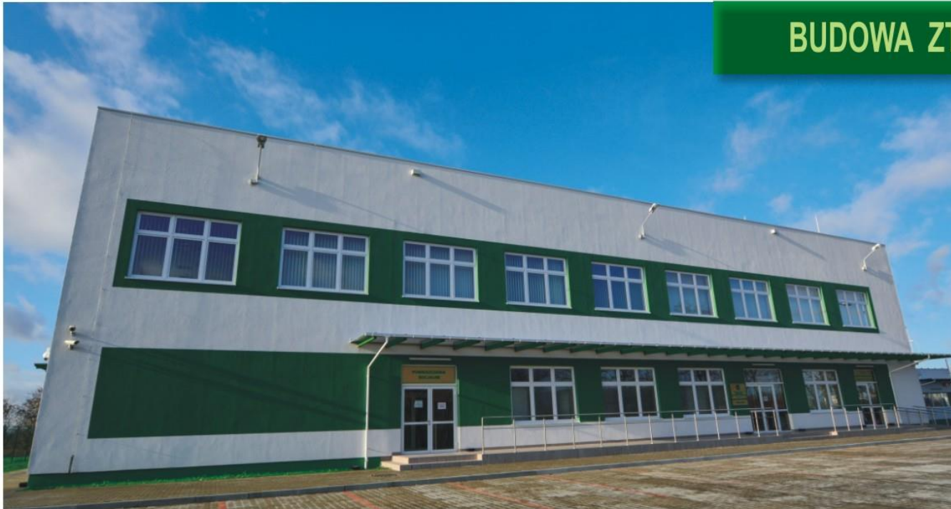
Budynek socjalno- administracyjny
