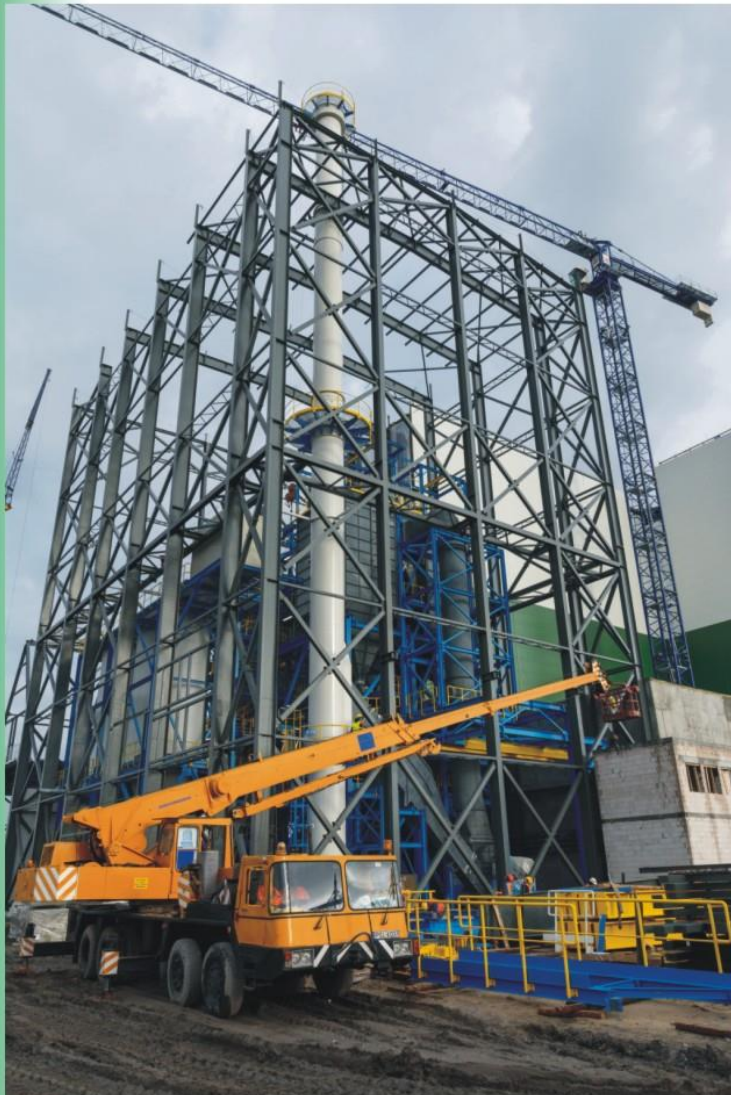
Konstrukcje stalowe pod obudowę węzła oczyszczania spalin
