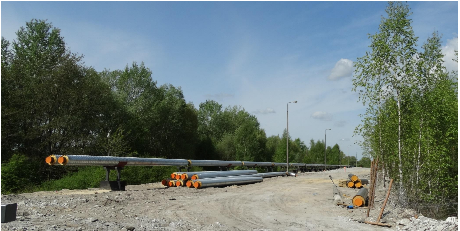
Cieplociąg wraz z podłączeniem do miejskiej sieci ciepłowniczej
